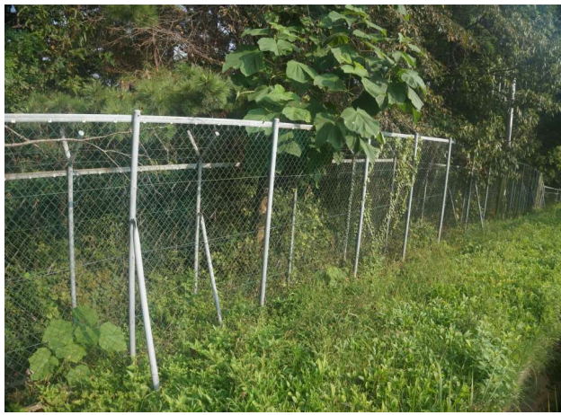
배수지 펜스 상태양호
