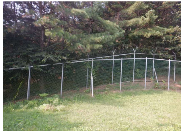
장내포장 파손(출입구 받침) 2024년 정밀[보수]
