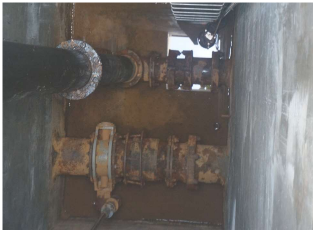
1지 유출밸브실 하부슬래브 채수
